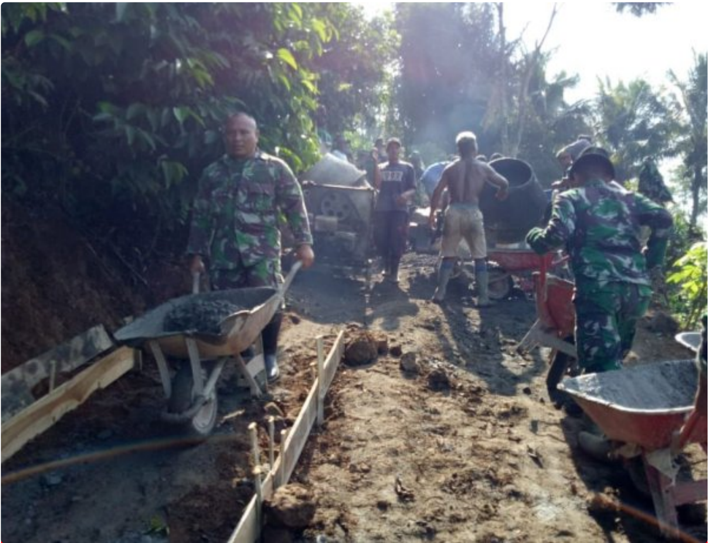
Satgas TMMD Kebut Pengecoran Jalan
